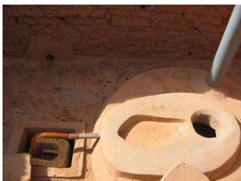
• Photo1 : Latrine à compost pour la Collecte séparée des urines et des fèces
