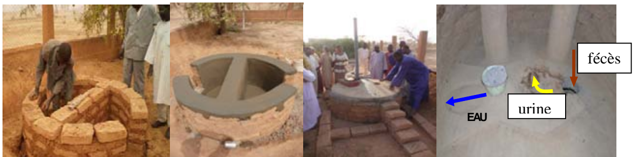
Figure 5 : Construction d'une latrine sèche
