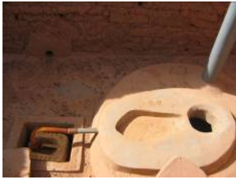
Photo1 : latrine à compost pour la collecte séparée des urines et des fèces
