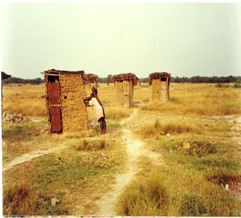
项目所在城镇里的一些普通的厕所
