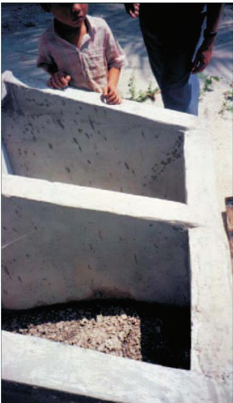
Рисунок 13. Фекальный материал следует собирать в двухсекционных контейнерах (ямах). Когда одна секция (яма) заполнена, она герметизируется и начинается отсчёт времени хранения, а в это время используется другая яма. Во Вьетнаме, где жаркий климат, полная гибель яиц *Ascaris* и типовых вирусов была достигнута в течение шести месяцев при данных условиях. Если не используются две ямы, то должно быть запланировано вторичное хранилище или другие типы обработки.
