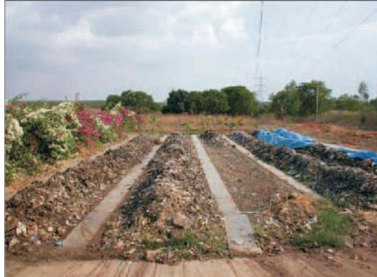
Рисунок 15. Компостирование фекалий вместе с бытовыми отходами в вентиляционных рядах. Фото: Дж. Гиб (J. Heeb).
