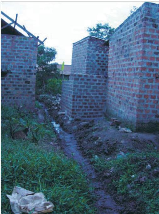
Рисунок 4. Содержимое из обычных вырытых уборных или безводных уборных никогда нельзя изымать и сливать в дренажные канавы. Загрязнение путем попадания фекалий человека в дренажные отводы для ливневых вод – основной риск передачи кишечных и паразитических заболеваний.
